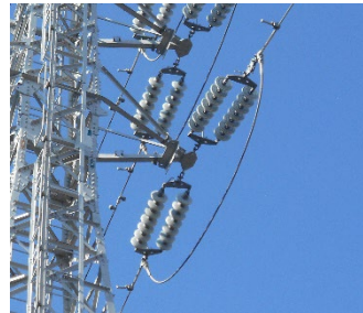
写真2 鉄塔と送電線を 絶縁する懸垂碍子
